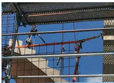
Работа за позициониране на динамични товари, особено при използване на многоклонови верижни сапани (напр. изграждане на турбини)
