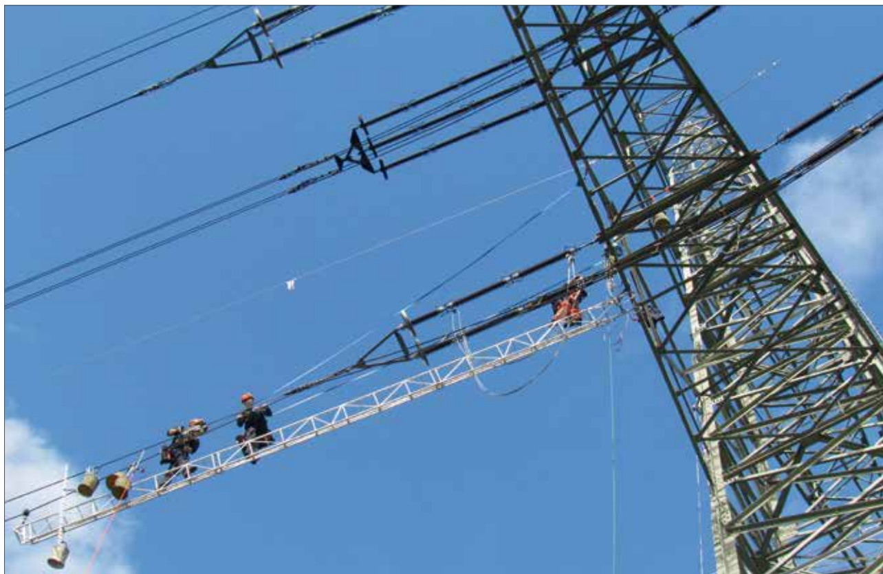
Изграждане на въздушна линия
