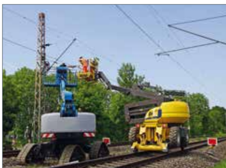
Изграждане на контактна линия
