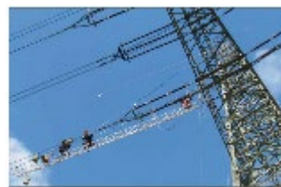
Изграждане на далекопроводи
