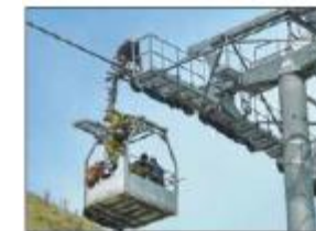
Изграждане на въжени линии
