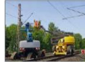
Изграждане на контактни линии
